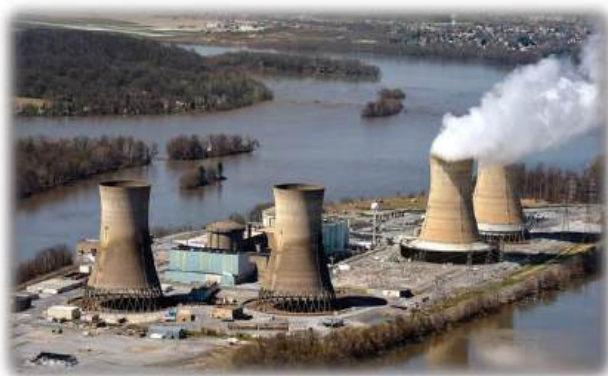
Fig. 4 – torri di raffreddamento di impianti nucleari tradizionali.
