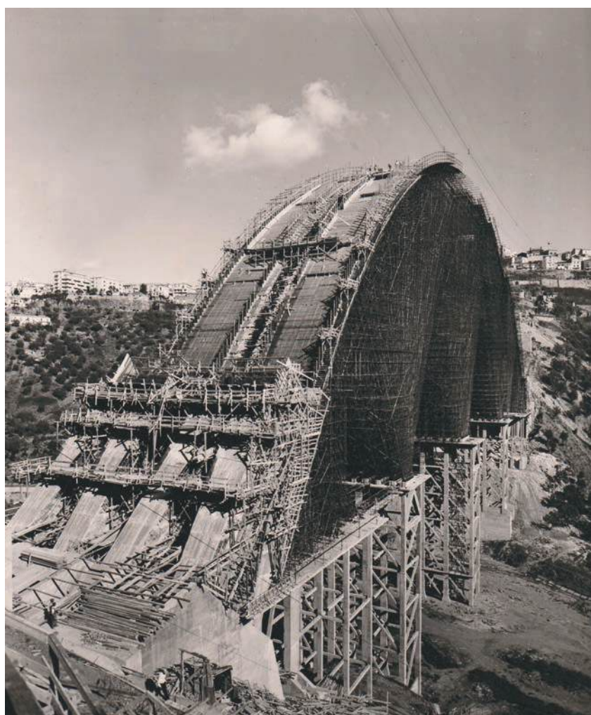
PONTE MORANDI A CATANZARO (1958 – 1962)
